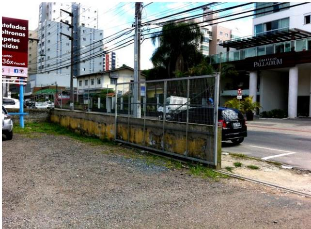
**FIG.03** – Parte do muro a ser quebrada e readequação do portão.
